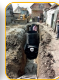
Slike 4. Prikaz ugradnje osnovnog modula digestora u okviru malog seoskog domaćinstva
