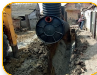
Slike 4. Prikaz ugradnje osnovnog modula digestora u okviru malog seoskog domaćinstva
